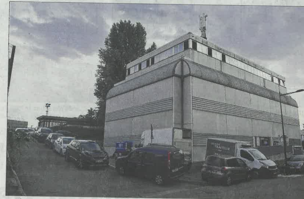
Le bâtiment actuel sera complètement transformé. Photo DNA/Laurent RÉA
